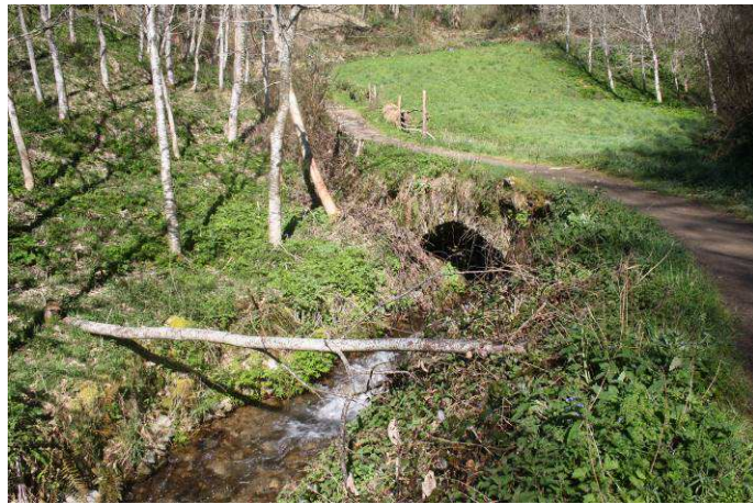
Lám. XI. 1.- División del Camino de Santiago a la salida de Las Herrerías de Valcarce; 2.- Camino de Santiago entre Las Herrerías de Valcarce y La Faba; 3.- Puente Romano de Boucelo sobre el arroyo de Refoxos.
